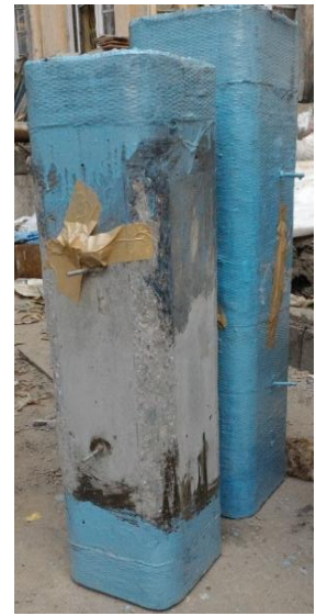
(d) Application of CFRP sheet
