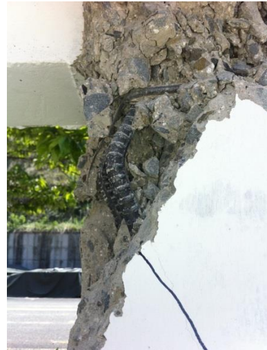
(d) Local buckling of longitudinal reinforcements
