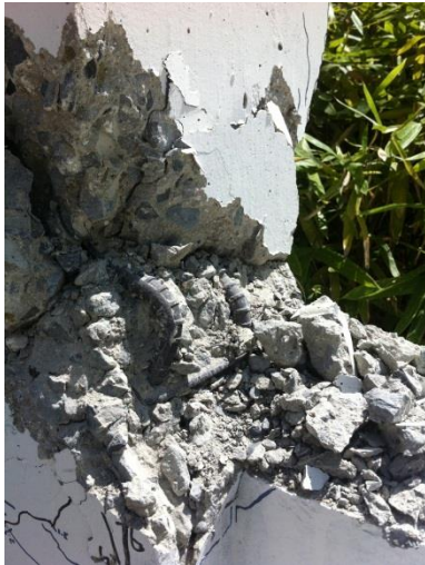
(d) Local buckling of longitudinal reinforcements
