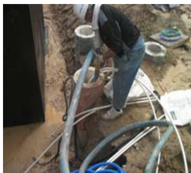
(d) Cement grouting
